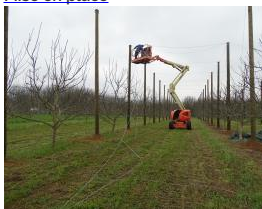
Mise en place
