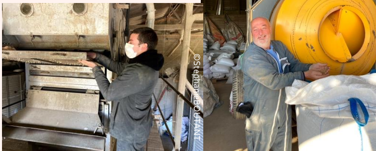
Légende : Matériels nécessaires à la technique (une bétonnière post fixe & un séparateur)
