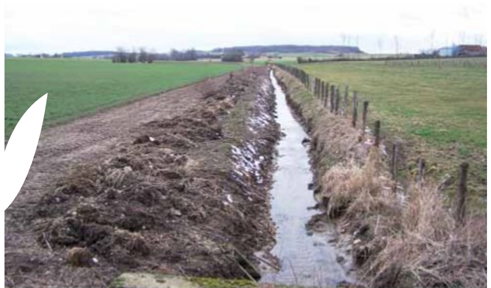
Curage d'un fossé
