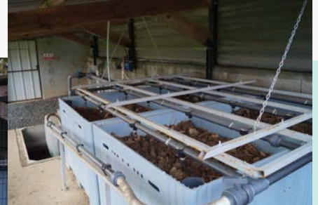
Phytobac® chez un agriculteur de Haute-Vienne : palox avec système d'épandage des effluents phytosanitaires récupérés depuis l'aire de lavage, avec cuve tampon intermédiaire
