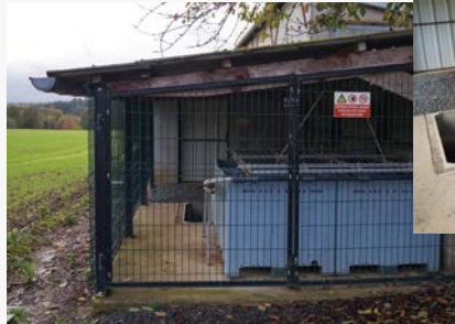
Phytobac® chez un agriculteur de Haute-Vienne : palox avec système d'épandage des effluents phytosanitaires récupérés depuis l'aire de lavage, avec cuve tampon intermédiaire
