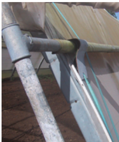
▲ Fixation latérale d'un abri anti-cyclone à Mayotte.
